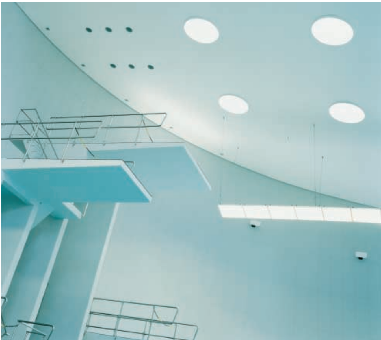
Eriksdalsbadet, Stockholm, Sweden. Architect: Erséus, Frenning & Sjögren Arkitektkontor AB. Contractor: Perakustik AB. Photo: Åke E-son Lindman.
